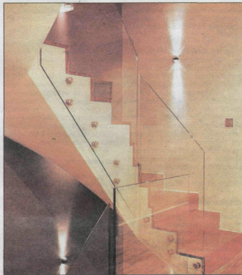
Do produkcji szklanych schodów czy balustrad używa się szkła warstwowego i laminowanego
